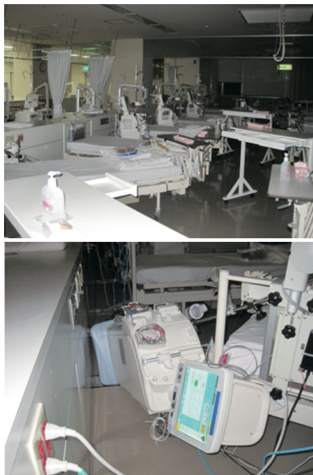
図1, 2 本震直後の透析室の被災状況
