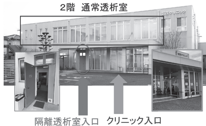
図5 賀茂クリニックの外観 隔離透析患者と通常の透析患者とは完全に動線が分かれるようにしている。
