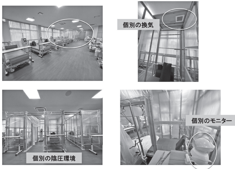
図7 隔離透析室10床のうち3床に新たにテントを設置
